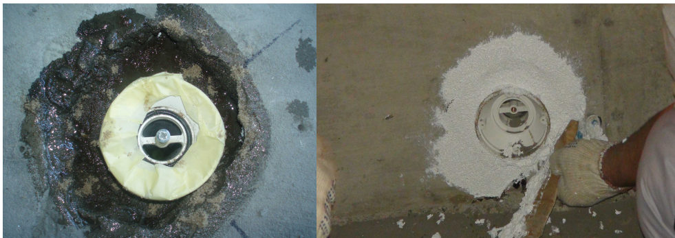
Грунтование с помощью PCI Eрохigrund 390 Зачеканка закладной с помощью PCI Durarox NT plus
